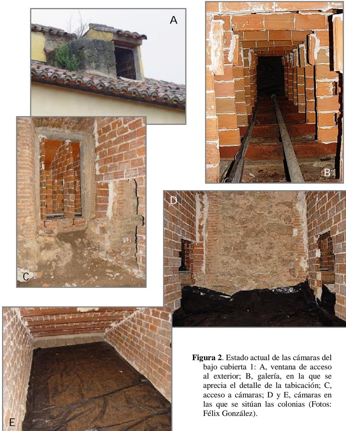
**Figura 2.** Estado actual de las cámaras del bajo cubierta 1: A, ventana de acceso al exterior; B, galería, en la que se aprecia el detalle de la tabicación; C, acceso a cámaras; D y E, cámaras en las que se sitúan las colonias (Fotos: Félix González).
