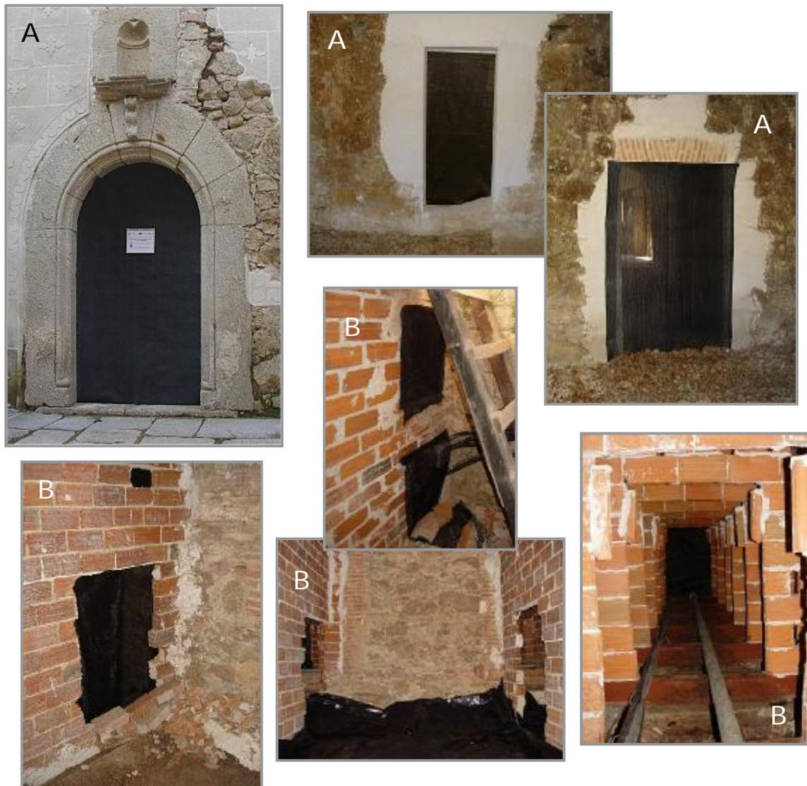
**Figura 8.** Algunos cierres instalados en la “casa del obispo” (A) y en el bajo cubierta del ala Sur del claustro plateresco (B). Fotos: Félix González.
