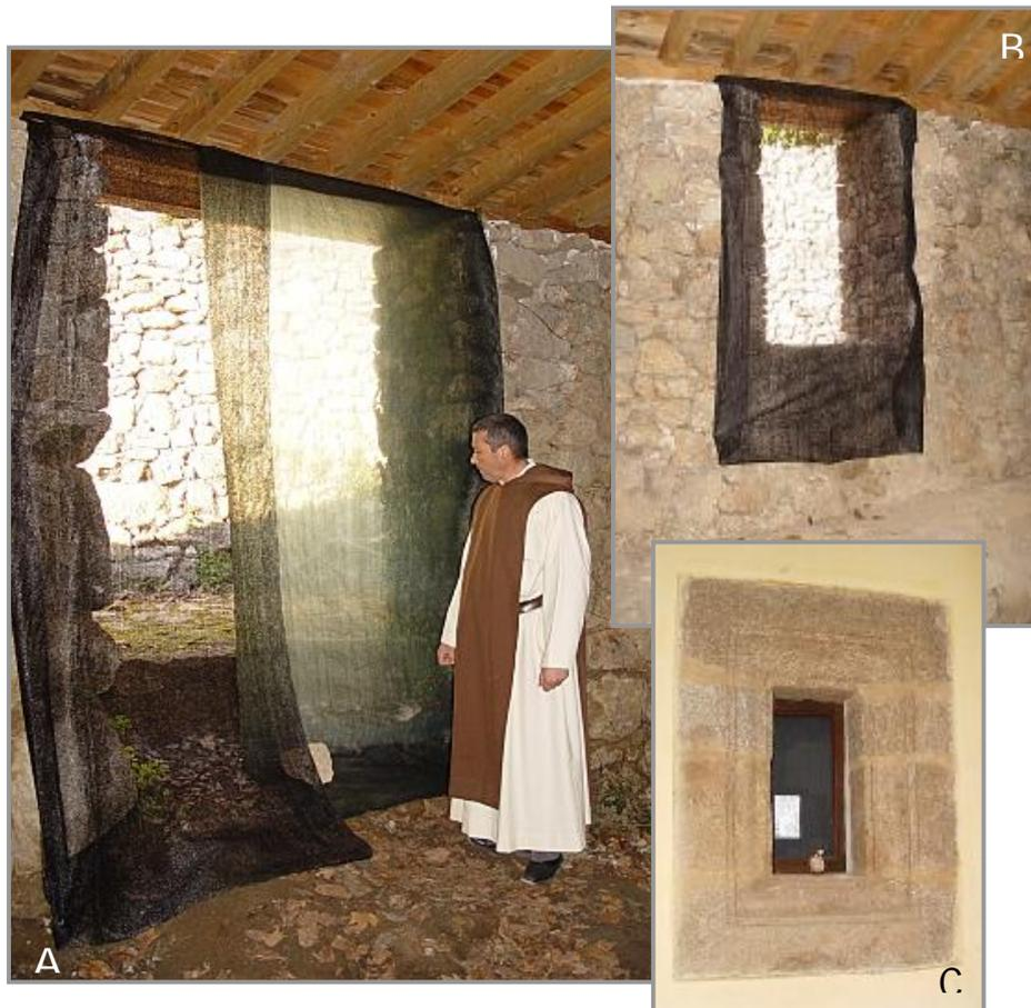
**Figura 7.** Distintos tipos de cierres instalados para impedir el paso de murciélagos durante los trabajos de conservación de las colonias de murciélagos en el monasterio de Yuste: A, cierre-cortina para permitir el acceso de personal (“casa del obispo”); B, cierre completo en una ventana; C, cierre con mosquitera en una ventana sin cristal (claustro plateresco). Fotos: Félix González.
