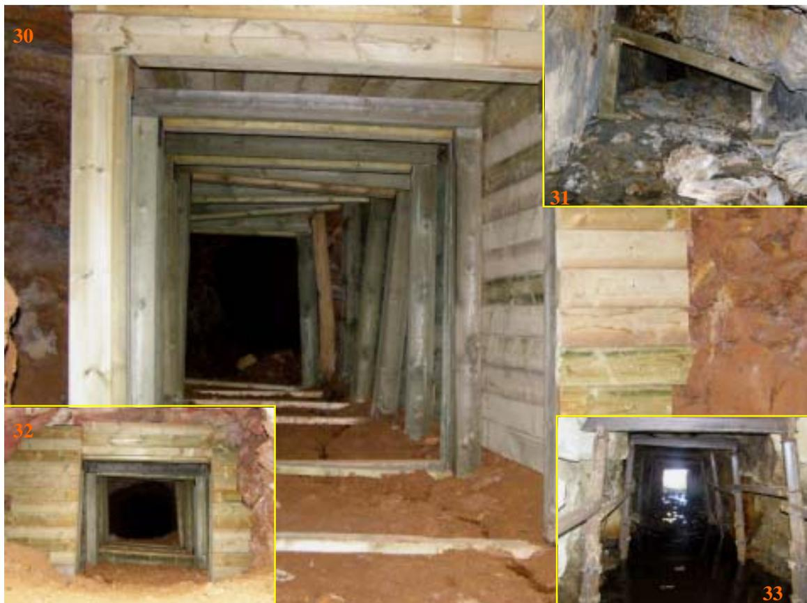
Foto 30, 31, 32: diferentes instalaciones para contener los posibles derrumbes.
