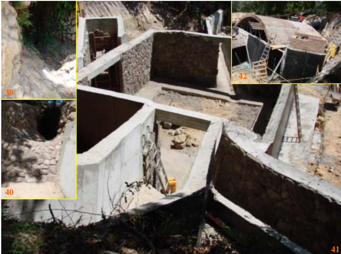
Foto 39 y 40: conexión de las nuevas galerías con al antigua mina de agua.
